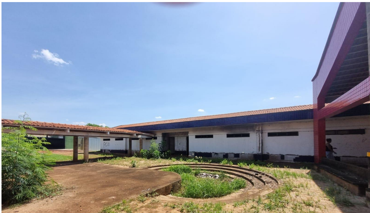
Imagem 34: Vista externa do bloco pedagógico I, apresentando passarela que liga os blocos executada. Sem instalação das portas e vidros das esquadrias, faltam componetes elétricos, revestimento cerâmico devido os mesmos se descolarem da alvenaria. Jardim repleto de vegetação rasteira. Fonte: O autor.
