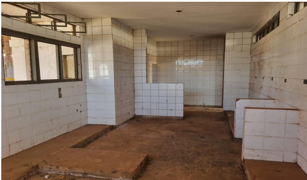
Imagem 17: Vista da cozinha, os vidros não foram instalados, piso em granitina não finalizado e se encontra em estado de deteriorização, bancadas não finalizadas, faltam de componetes hidráulicos e elétricos, áreas sem revestimento cerâmico devido os mesmos se descolarem da alvenaria, e sem louças e acessórios. Fonte:
