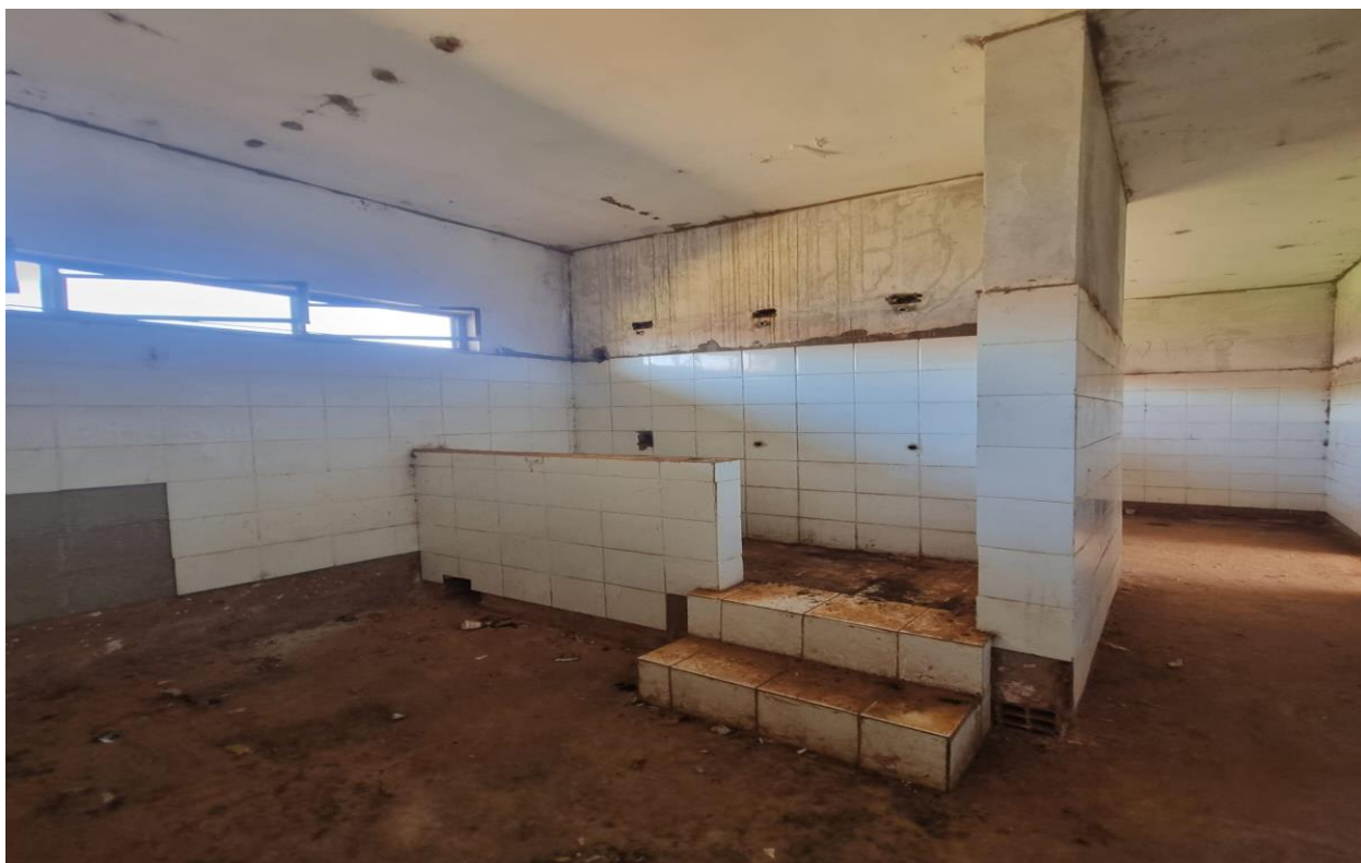
Imagem 32: Vista do sanitário da sala Creche II sem instalação das portas e vidros das esquadrias, faltam componentes elétricos e hidráulicos, e peças e acessórios. Fonte: O autor.
