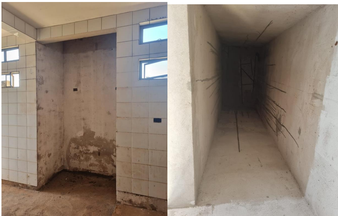
Imagem 16: Vista da cozinha, detalhe do local a ser instalado sistema de exaustão mecânica, não executado.
