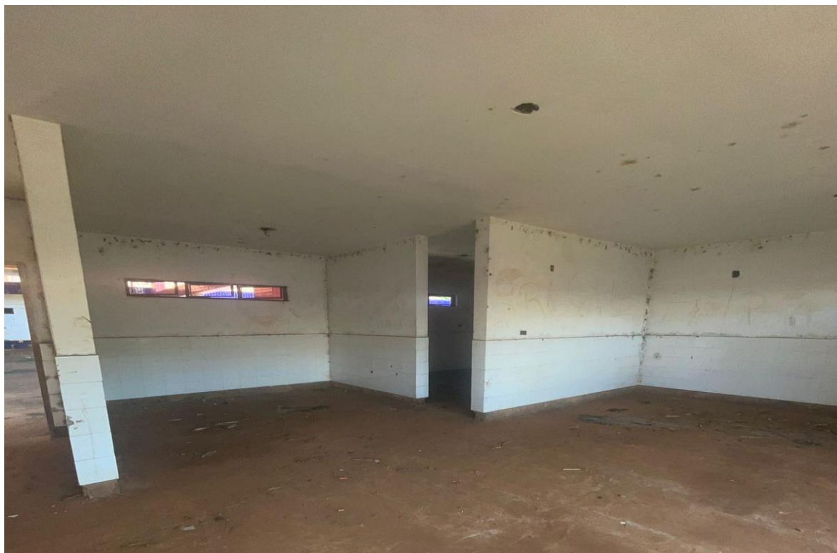
Imagem 25: Vista de dentro da sala Creche I, sem instalação dos vidros e portas, e dos componentes elétricos, com pontos faltando revestimento cerâmico dentro dos sanitários devido os mesmos se descolarem da alvenaria, faltando instalações hidráulicas, piso em granitina não finalizado e divisória não executada. Fonte: O autor
