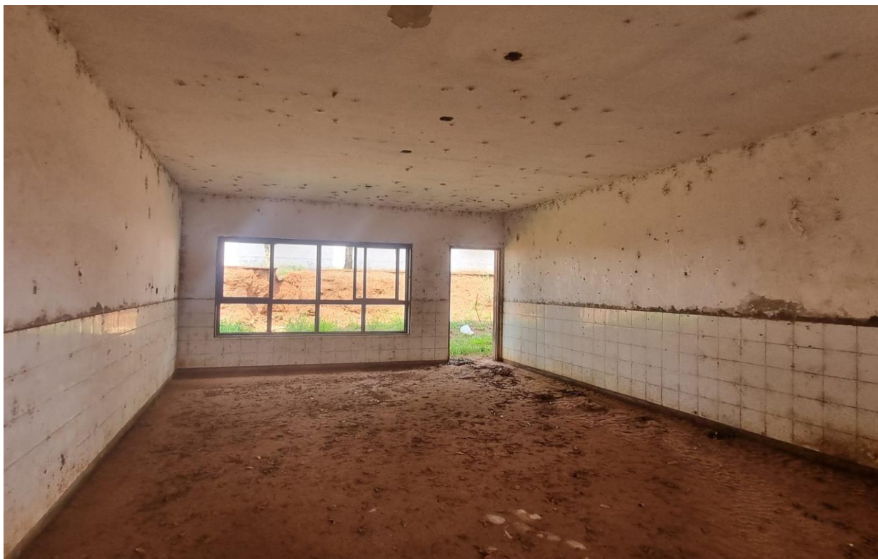
Imagem 36: Vista da sala Pré escola, sem instalação das portas e vidros das esquadrias, faltam componentes elétricos, piso em granitida não finalizado e se encontra em estado de deteriorização. Fonte: O autor.
