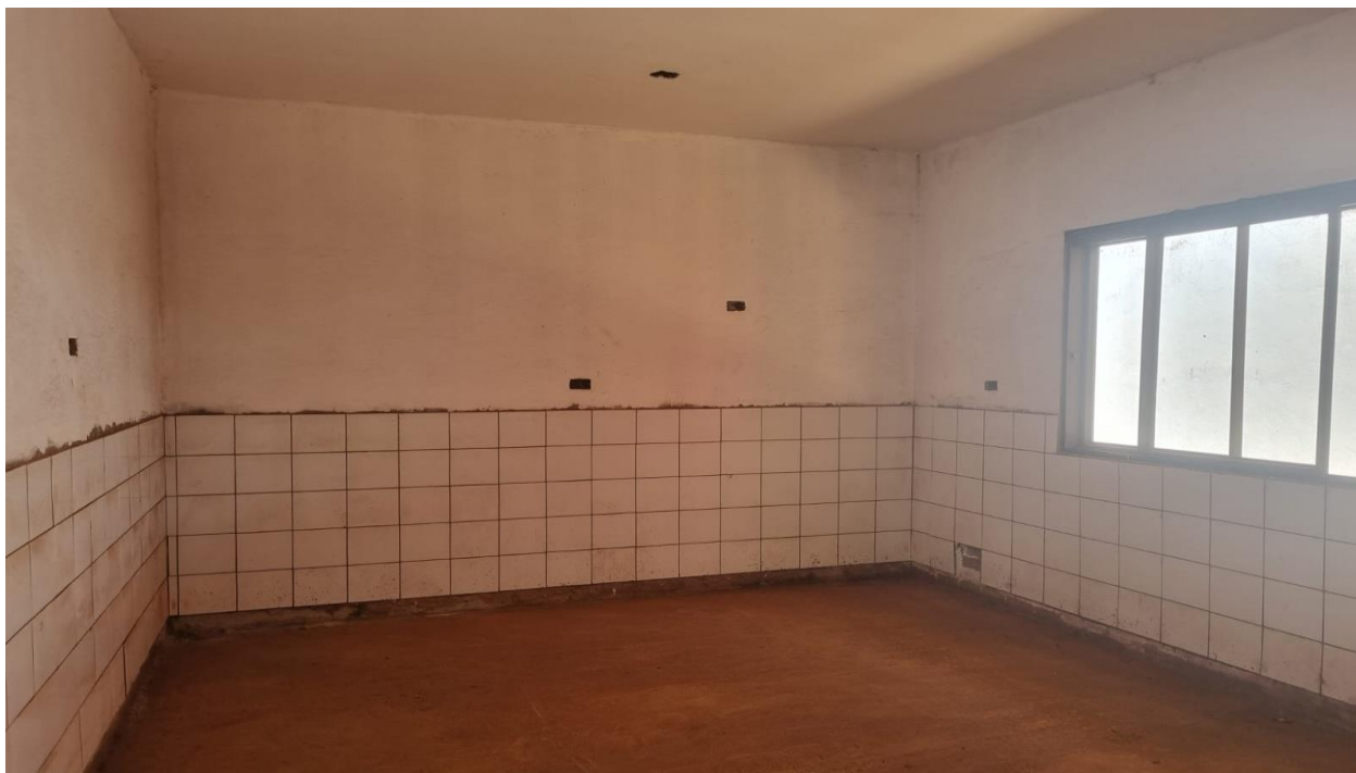
Imagem 05: almoxarifado, sem instalação dos vidros, portas, sem instalação dos componentes elétricos, com pontos faltando revestimento devido os mesmos se descolaram da alvenaria cerâmico, piso em granitina não finalizado. Fonte: O autor.
