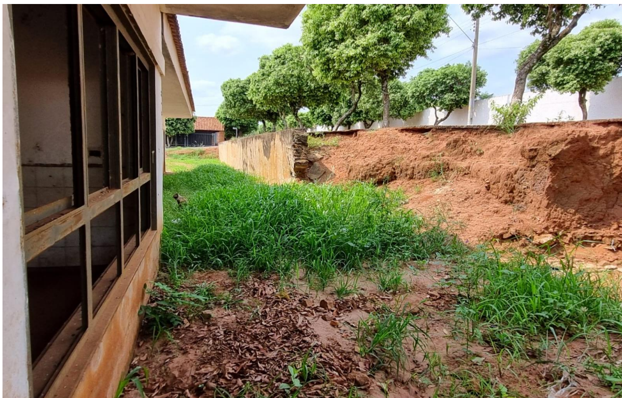
Imagem 50: Vista lateral onde foi executado o muro de arrimo, porém por falhas de execução cerca de 50% cedeu. Fonte: O autor.
