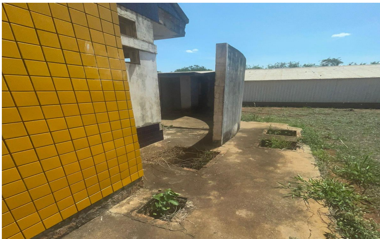
Imagem 57: Caixas de inspeção e gorduras abertas com vegetação. Fonte: O autor.
