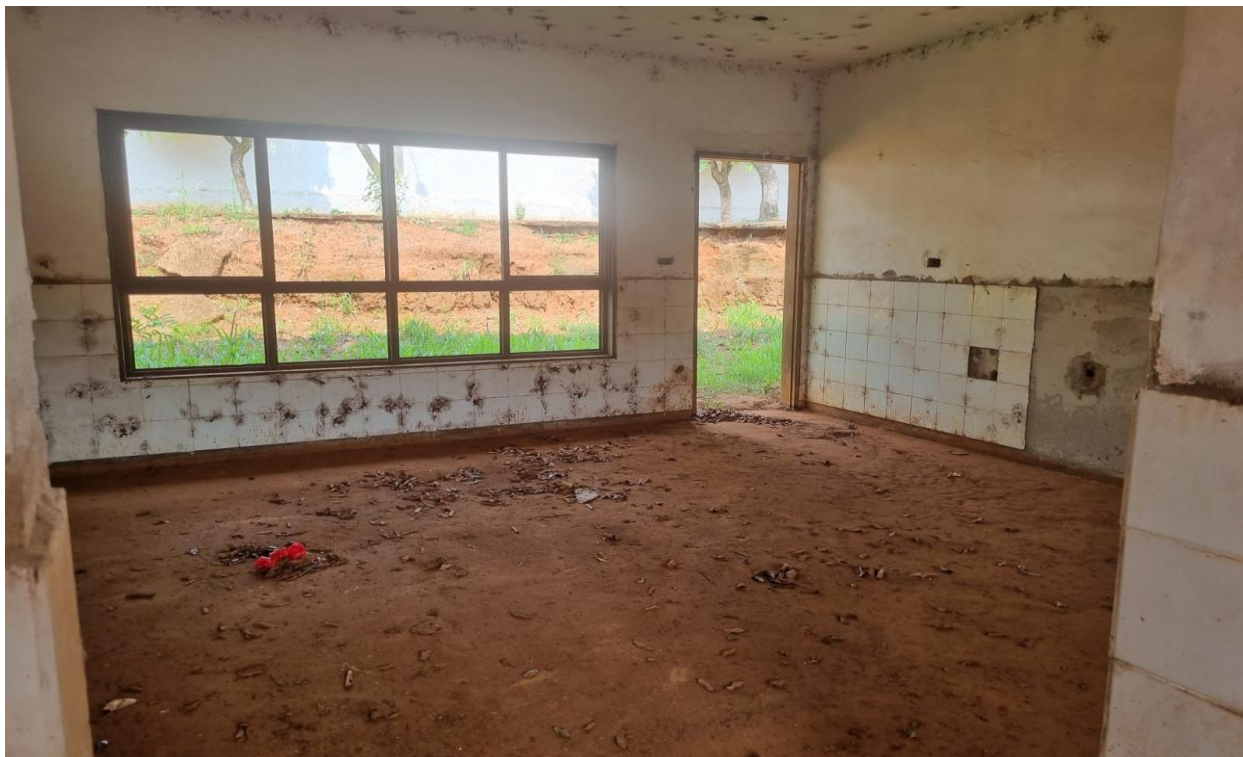
Imagem 37: Vista da sala Creche III, sem instalação das portas e vidros das esquadrias, faltam componentes elétricos, piso em granitida não finalizado e se encontra em estado de deteriorização. Fonte: O autor.
