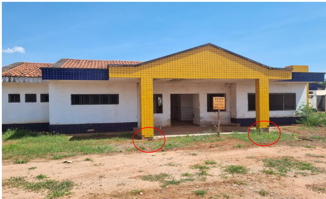
Imagem 03: fachada da edificação, locais onde o piso cerâmico (10x10cm) devido os mesmos se descolarem da alvenaria. Fonte: O autor.
