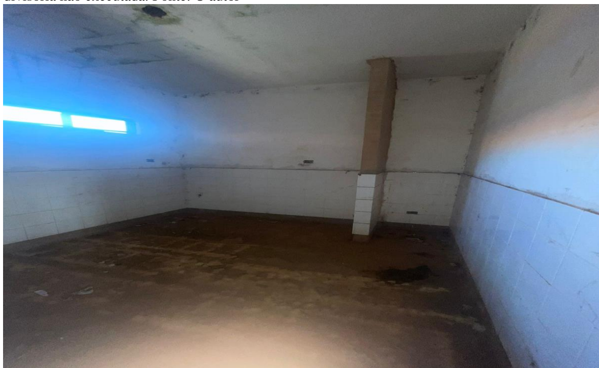
Imagem 26: Vista de dentro fraldário da sala Creche I, sem instalação dos vidros e portas, e dos componentes elétricos, com pontos faltando revestimento cerâmico dentro dos sanitários devido os mesmos se descolarem da alvenaria, faltando instalações hidráulicas, piso em granitina não finalizado e divisória não executada. Fonte: O autor
