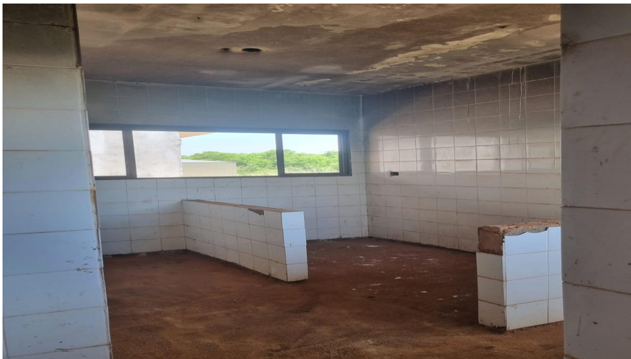
Imagem 19: Vista da lavanderia, os vidros não foram instalados, piso em granitina não finalizado e se encontra em estado de deteriorização, bancadas não finalizadas, faltam componetes hidráulicos e elétricos, áreas sem revestimento cerâmico devido os mesmos se descolarem da alvenaria, sem louças e acessórios,
