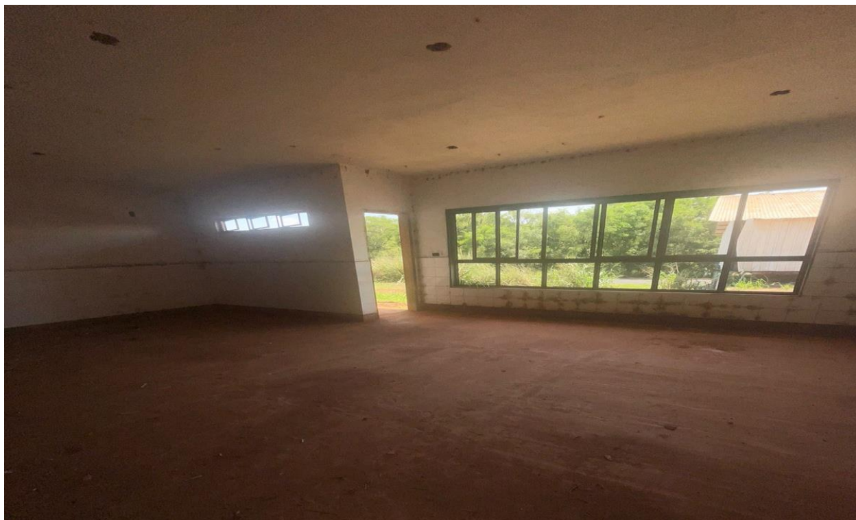
Imagem 27: Vista de dentro da sala Creche II, sem instalação dos vidros e portas, e dos componentes elétricos, com pontos faltando revestimento cerâmico dentro dos sanitários devido os mesmos se descolarem da alvenaria, faltando instalações hidráulicas, piso em granitina não finalizado e divisória não executada. Fonte: O autor
