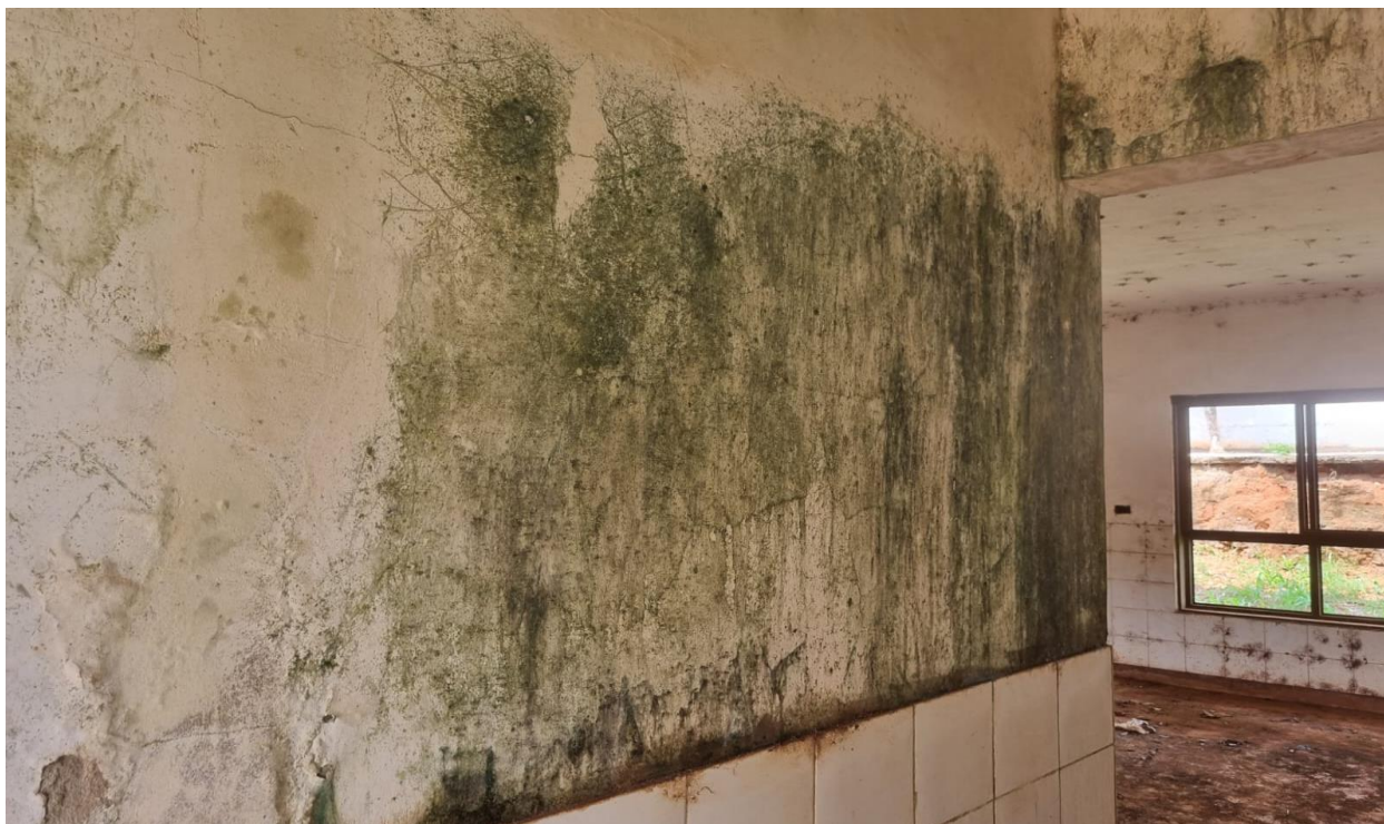
Imagem 40: Vista da sala Creche III, sem instalação das portas e vidros das esquadrias, faltam componetes elétricos, paredes e laje com presença limo oriundo de humidade, piso em granitida não finalizado e se encontra em estado de deteriorização. Fonte: O autor.
