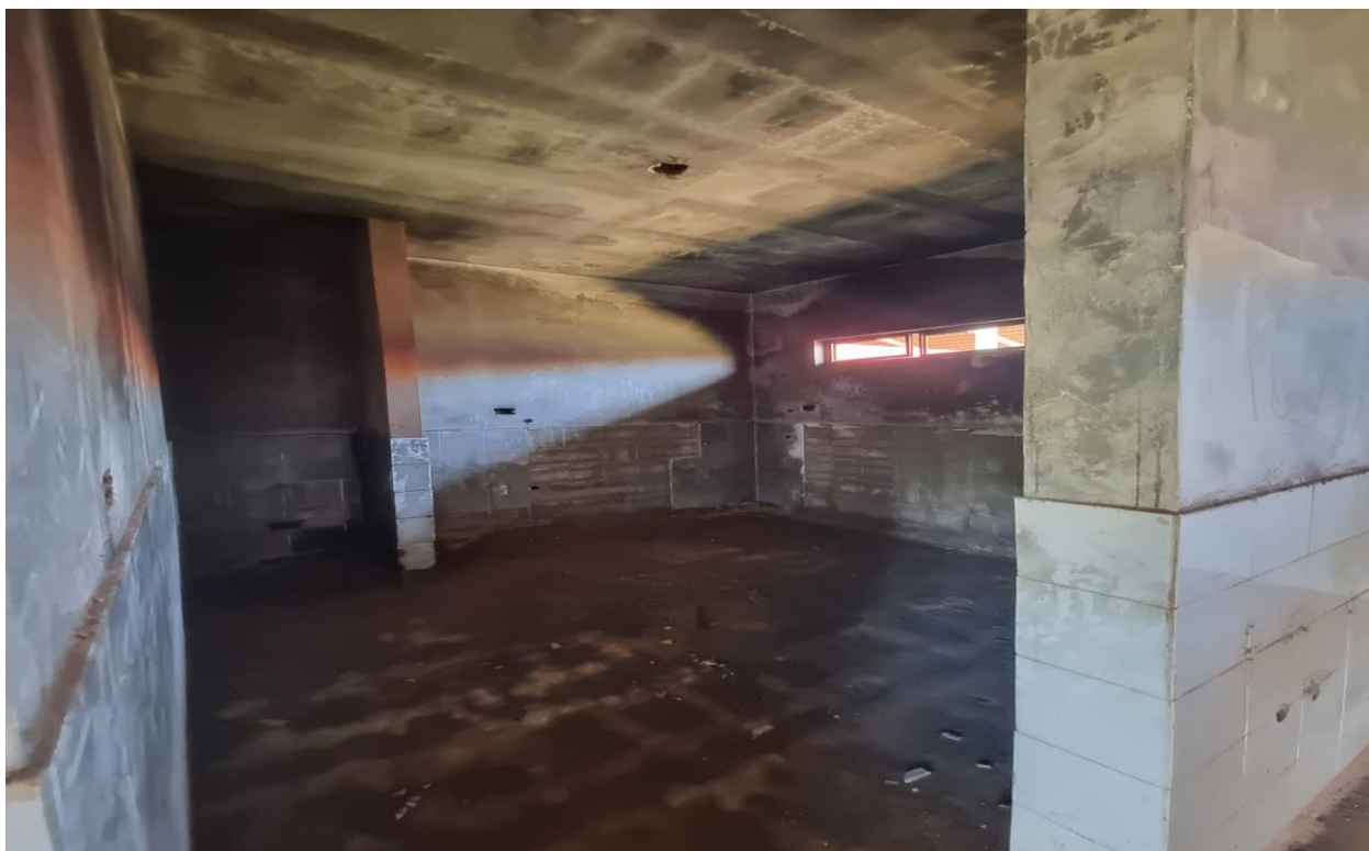
Imagem 31: Vista sanitário sala Creche I, sem instalação das portas e vidros das esquadrias, faltam componentes elétricos e hidráulicos, peças e acessórios, e a área foi incendiada. Fonte: O autor.
