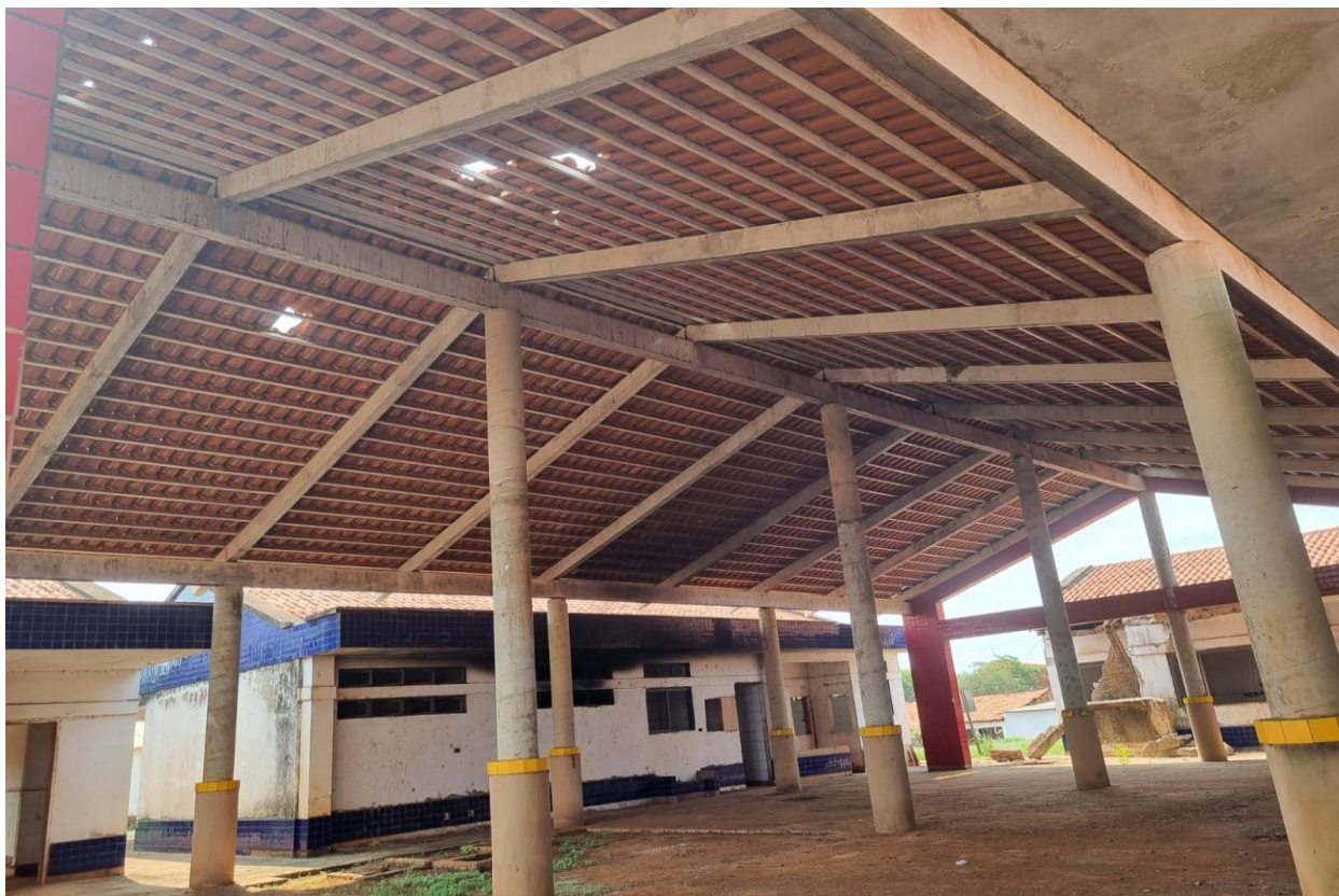
Imagem 53: Vista do Pátio coberto, não instalado telhas de vidro. Fonte: O autor.
