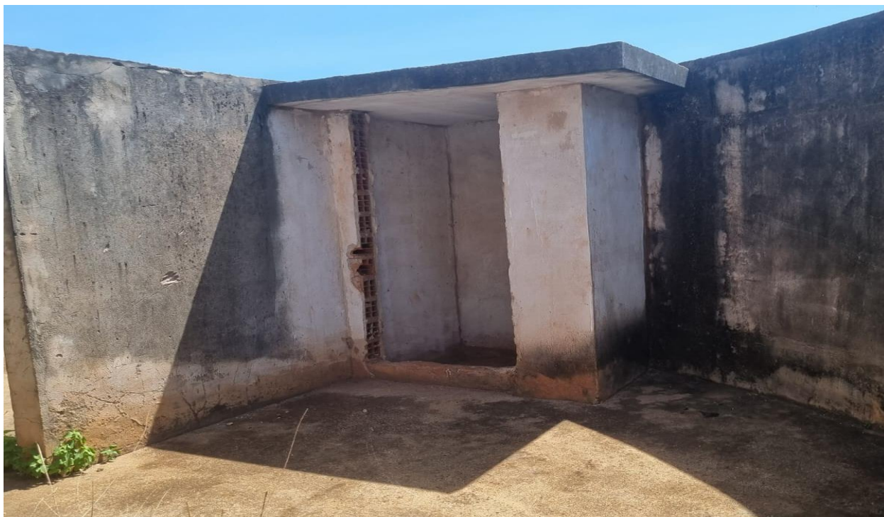
Imagem 12: Vista da Central de GLP, não finalizada, com ausência de componetes conforme projeto e sem indícios de instalação de tubulação de abastecimento ao prédio. Fonte: O autor.
