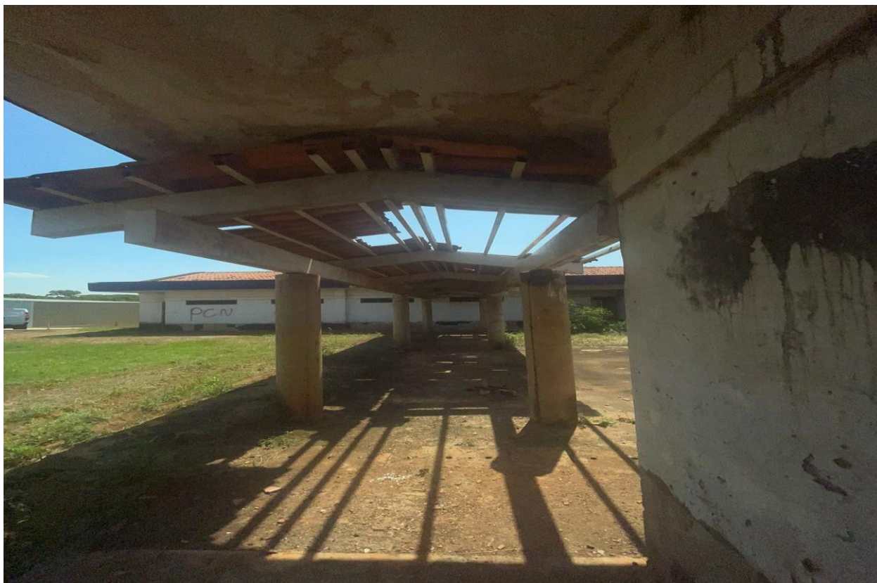
Imagem 55: Passarela que liga os blocos pedagógicos I e II, com partes que foram destelhadas. Fonte: O autor.
