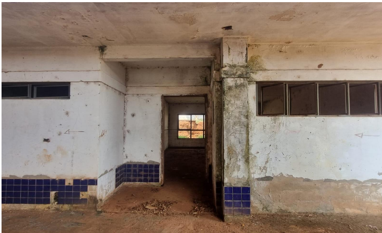
Imagem 41: Vista da sala Creche III, sem instalação das portas e vidros das esquadrias, faltam componetes elétricos, paredes e laje com presença limo oriundo de humidade, piso em granitida não finalizado e se encontra em estado de deteriorização. Fonte: O autor.
