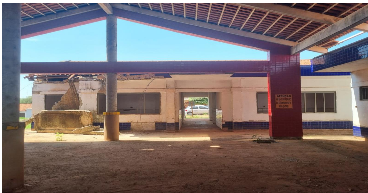
Imagem 09: Vista de dentro do prédio do bloco de administração, onde além de pontos sem o revestimento cerâmico devido os mesmos se descolarem da alvenaria, a laje em balanço externa cedeu, comprometendo o restante. Fonte: O autor.
