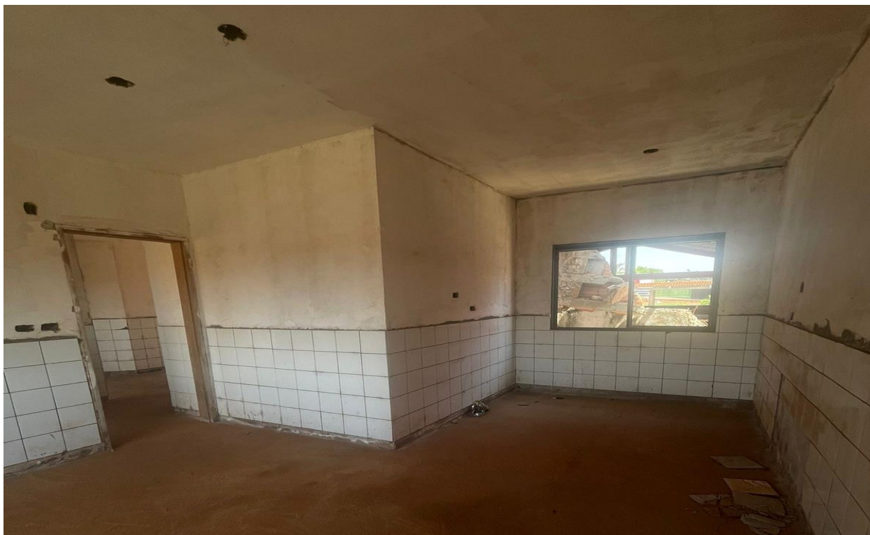
Imagem 03: Diretoria, sem instalação dos vidros, portas, sem instalação dos componentes elétricos, com pontos faltando revestimento cerâmico devido os mesmos se descolarem da alvenaria. Fonte: O autor.
