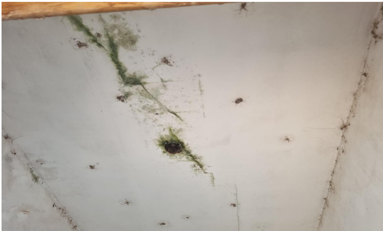
Imagem 39: Vista da sala Creche III, sem instalação das portas e vidros das esquadrias, faltam componetes elétricos, laje com presença limo oriundo de humidade, piso em granitida não finalizado e se encontra em estado de deteriorização. Fonte: O autor.
