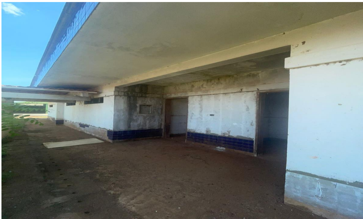
Imagem 29: Vista área de circulação acesso as salas da Creche II, sem instalação das portas e componetes, piso em granitina não finalizado e se encontra em estado de deteriorização, áreas sem revetimento cerâmico. Fonte: O autor.
