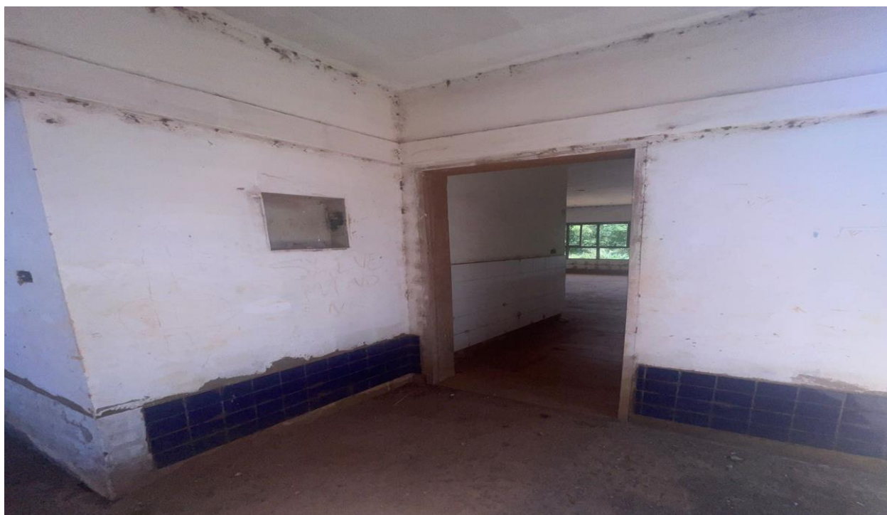
Imagem 28: Vista porta de acesso da sala Creche II, sem instalação das portas e componetes, sem instalação de um dos quadros de energia, piso em granitina não finalizado e se encontra em estado de deteriorização. Fonte: O autor.
