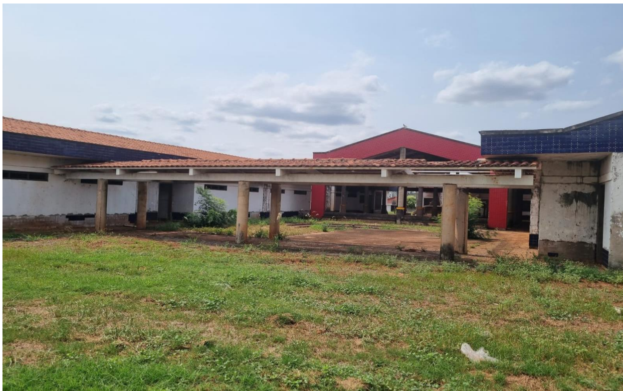
Imagem 54: Vista da passarela, com ausência em alguns pontos de telha e cumeeira. Fonte: O autor.
