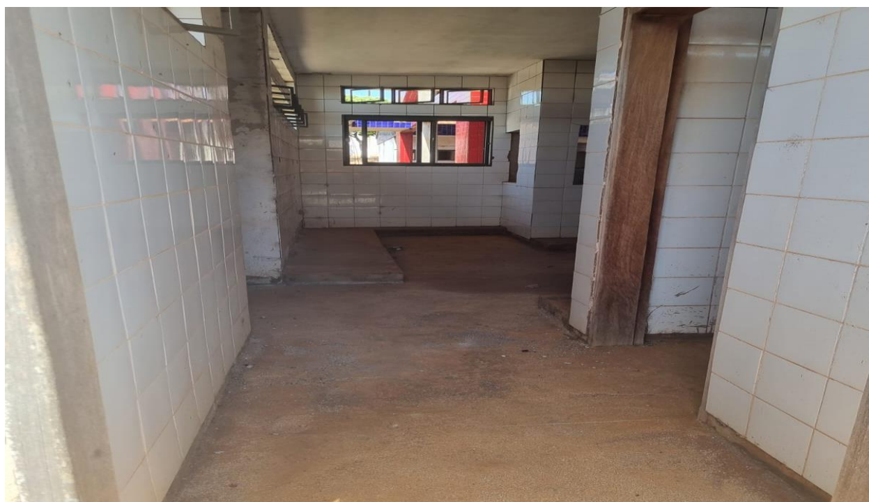
Imagem 15: Vista da cozinha, entrada pela da área externa do bloco de serviços, os vidros não foram instalados, piso em granitina não finalizado, e se encontra em estado de deteriorização. Fonte: O autor.
