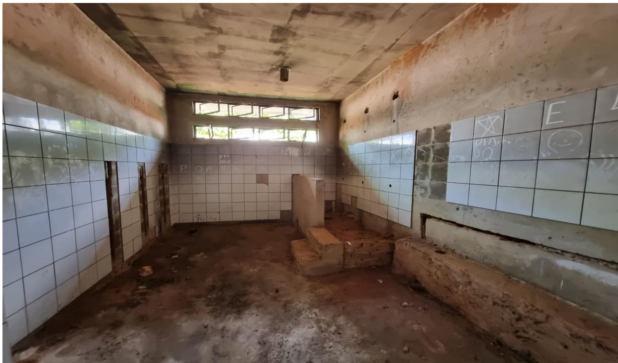
Imagem 43: Vista sanitário bloco pedagógico, sem instalação das portas e vidros das esquadrias, faltam componetes elétricos, paredes e laje com vestigio de incêndio, piso em granitida não finalizado e se encontra em estado de deteriorização. Fonte: o autor.
