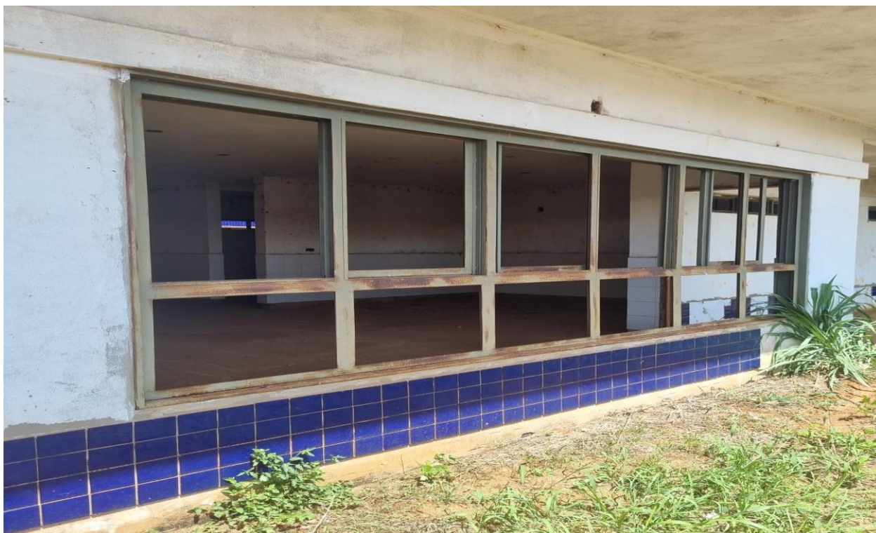
Imagem 33: Vista externa do bloco pedagógico I, faltando revestimentos cerâmicos devido os mesmos se descolarem da alvenaria, vidros e grades de proteção nas esquadrias, que apresentam sinais de oxidação. Fonte: O autor.
