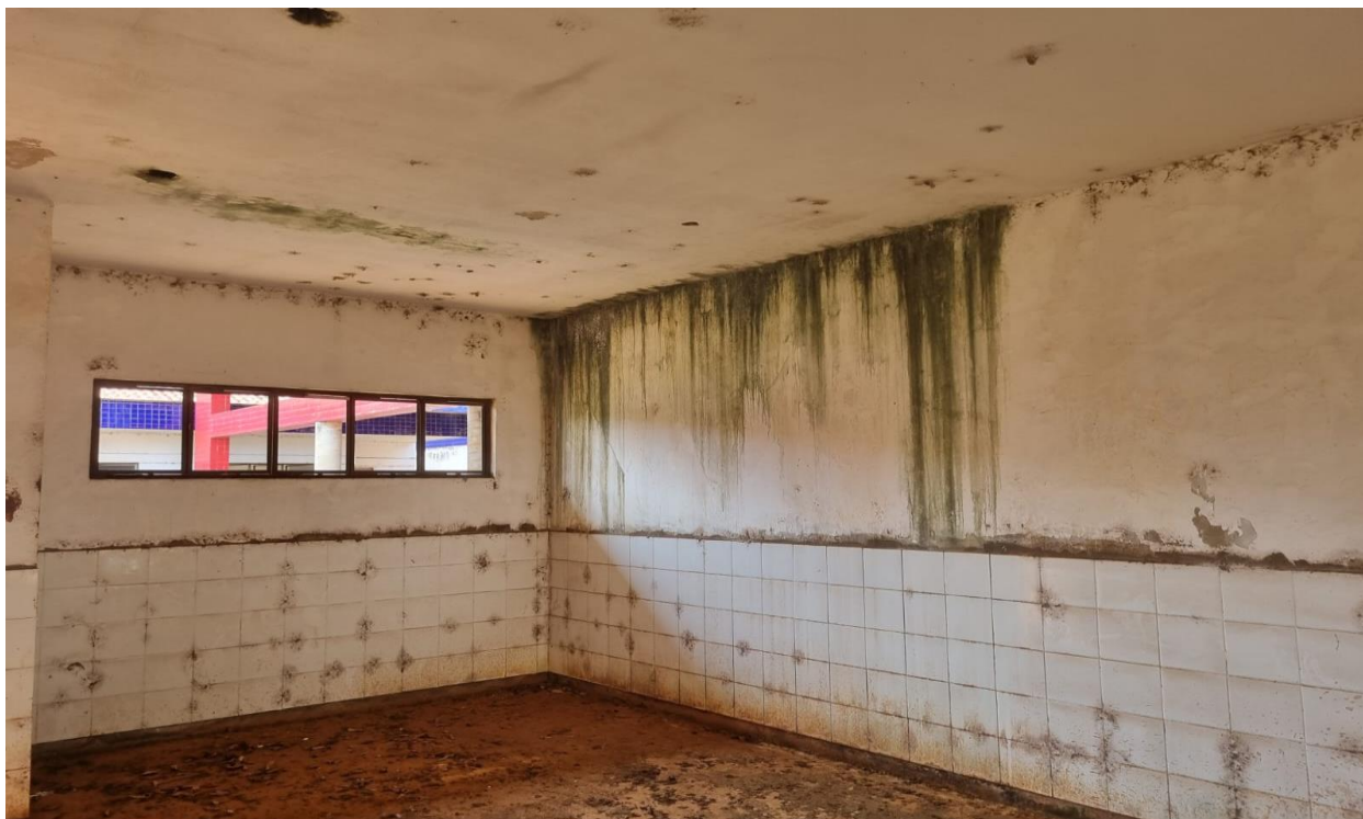
Imagem 42: Vista pré escola, sem instalação das portas e vidros das esquadrias, faltam componetes elétricos, paredes e laje com presença limo oriundo de humidade, piso em granitida não finalizado e se encontra em estado de deteriorização. Fonte: O autor.
