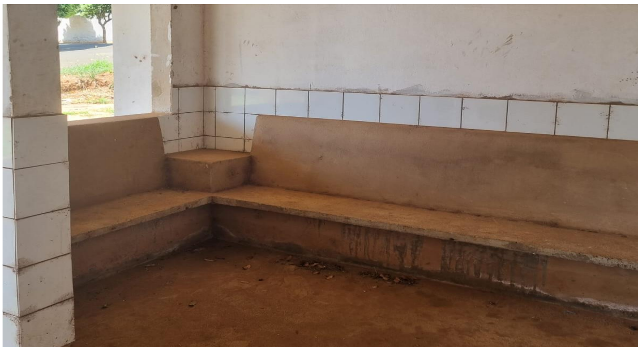
Imagem 04: Bancos de concreto não finalizados. Fonte: O autor.
