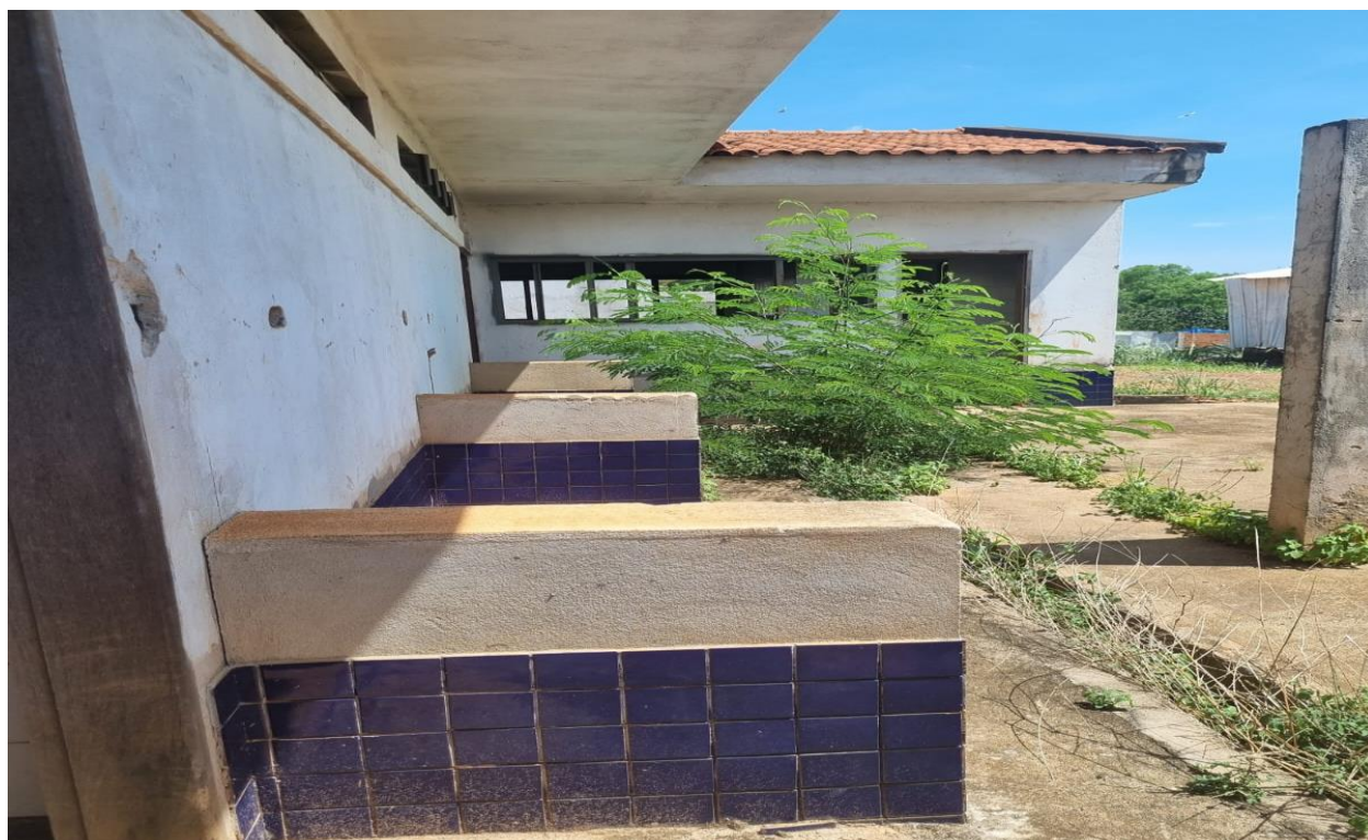
Imagem 14: Vista da área externa do bloco de serviços, onde foi iniciada a execução da bancada externa, áreas sem revestimento cerâmico devido os mesmos se descolarem da alvenaria, sendo possível ver também o sistema de água pluvial exposto (sem tampa tipo grelha) e excesso de vegetação rasteira. Fonte: O autor.
