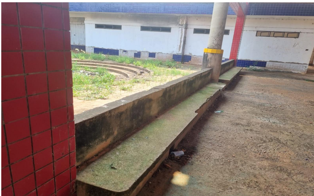
Imagem 52: Vista do pátio coberto, detalhe aos bancos que foram parcialmente danificados e com lodo, resultado de umidade. Fonte: O autor.
