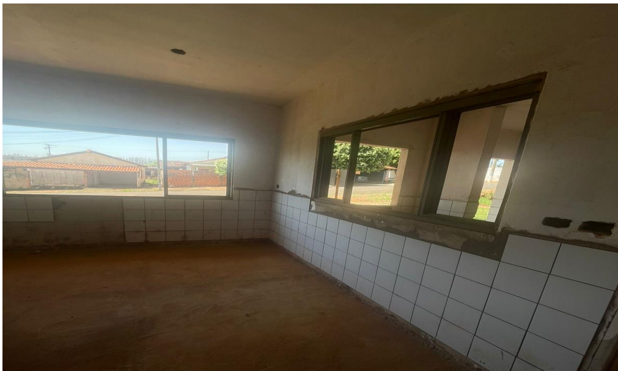
Imagem 02: Secretaria, sem instalação dos vidros, portas, sem instalação dos componentes elétricos, com pontos faltando revestimento cerâmico devido os mesmos se descolarem da alvenaria. Fonte: O autor.
