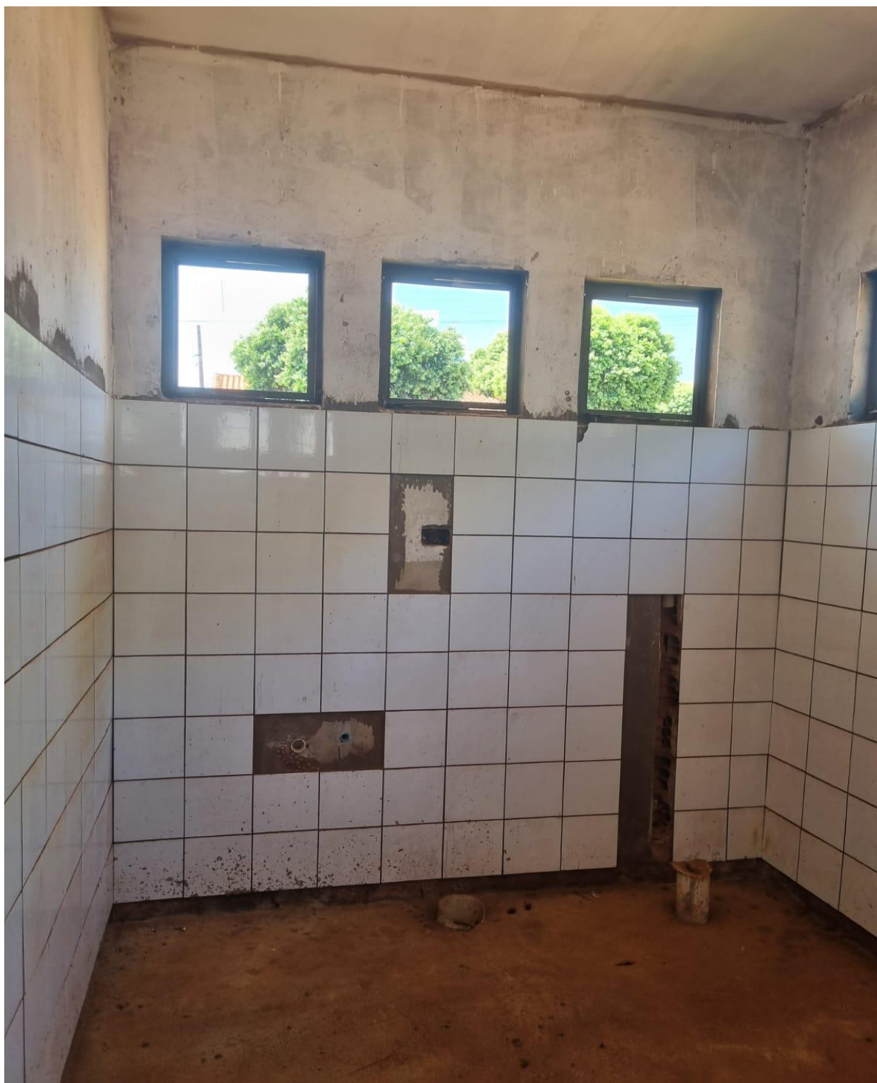
Imagem 08: Sanitários do bloco de administração, sem instalação dos vidros, portas, sem instalação dos componentes elétricos, com pontos faltando revestimento cerâmico devido os mesmos se descolarem da alvenaria, piso em granitina não finalizado. Fonte: O autor.
