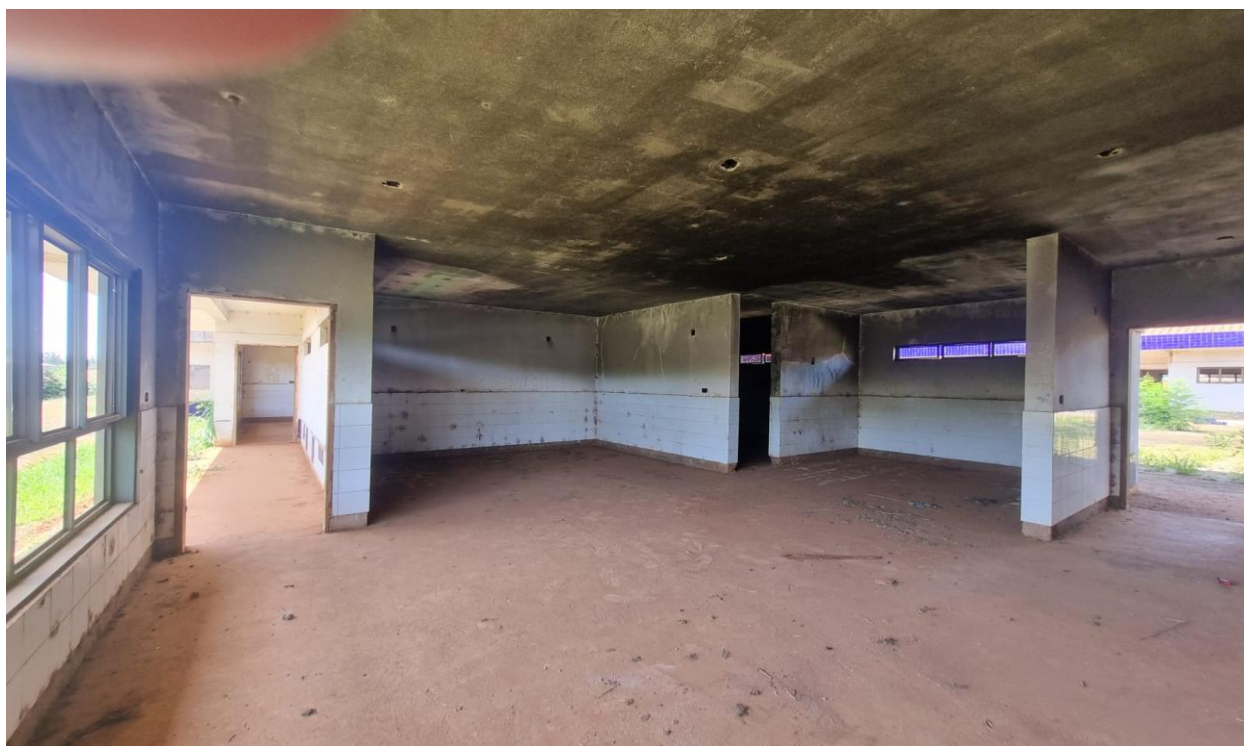
Imagem 35: Vista da sala Creche I, sem instalação das portas e vidros das esquadrias, faltam componetes elétricos e hidráulicos, peças e acessórios, área foi incendiada, piso em granitida não finalizado e em estado de deteriorização. Fonte: O autor.
