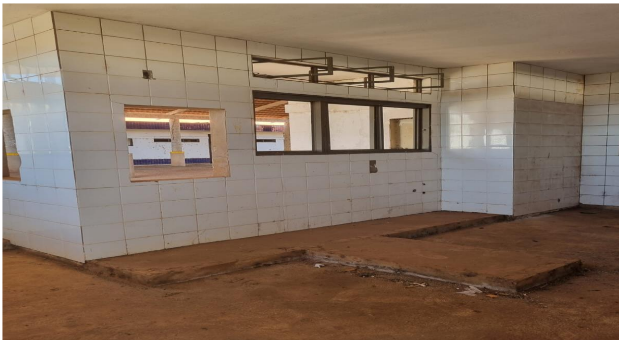
Imagem 18: Vista da cozinha, os vidros não foram instalados, piso em granitina não finalizado e se encontra em estado de deteriorização, bancadas não finalizadas, faltam componetes hidráulicos e elétricos, áreas sem revestimento cerâmico devido os mesmos se descolarem da alvenaria, e sem louças e acessórios. Fonte: O autor.
