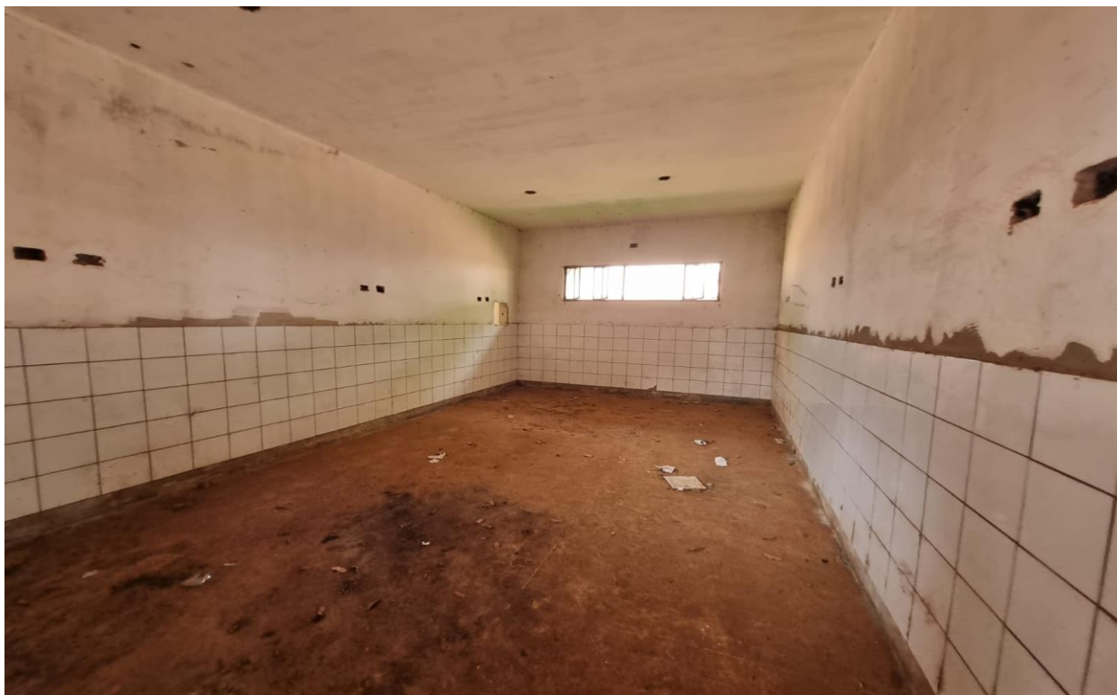
Imagem 38: Vista da sala multiuso, sem instalação das portas e vidros das esquadrias, faltam componetes elétricos, piso em granitida não finalizado e se encontra em estado de deteriorização. Fonte: O autor.
