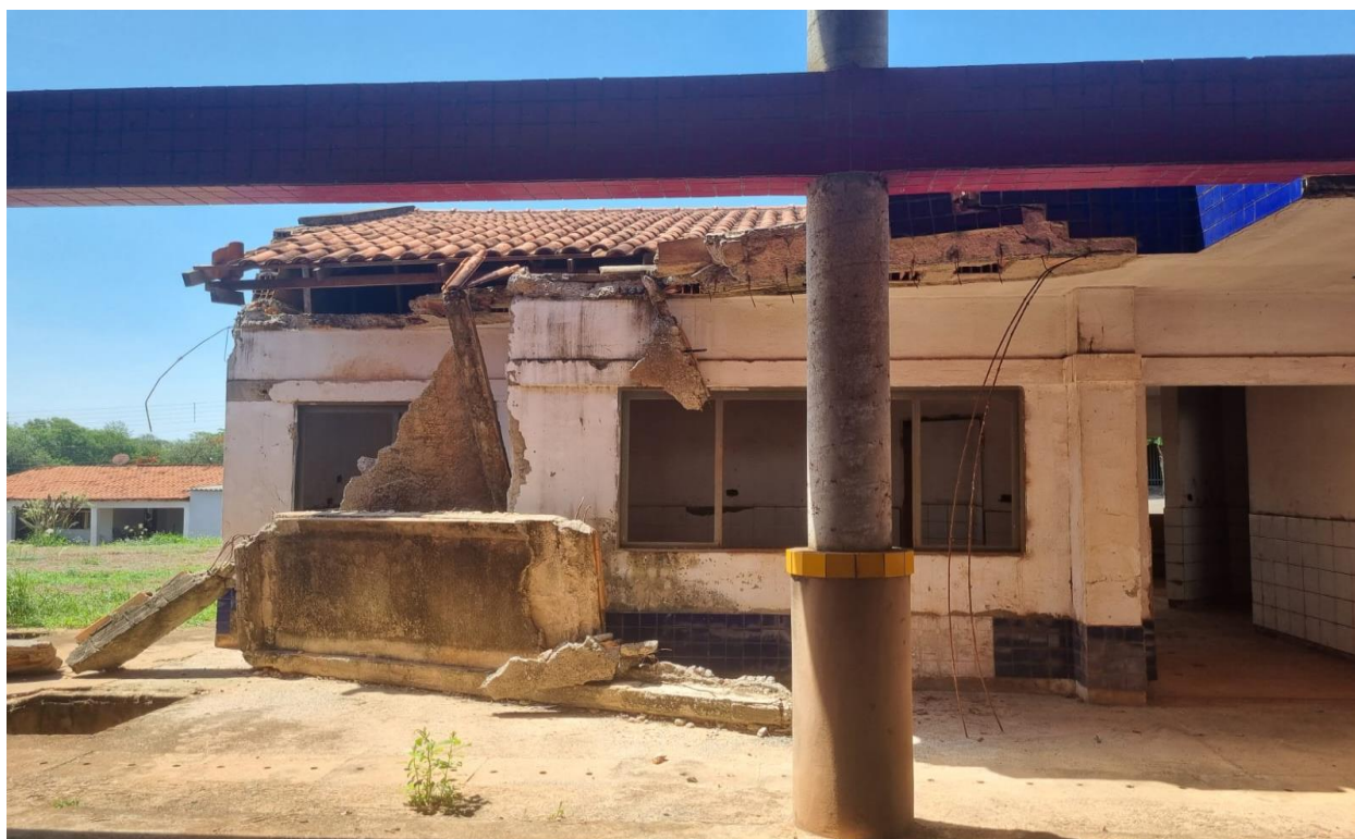
Imagem 10: Vista de dentro do prédio do bloco de administração, onde além de pontos sem o revestimento cerâmico devido os mesmos se descolarem da alvenaria, a laje em balanço externa cedeu, comprometendo o restante. Fonte: O autor.
