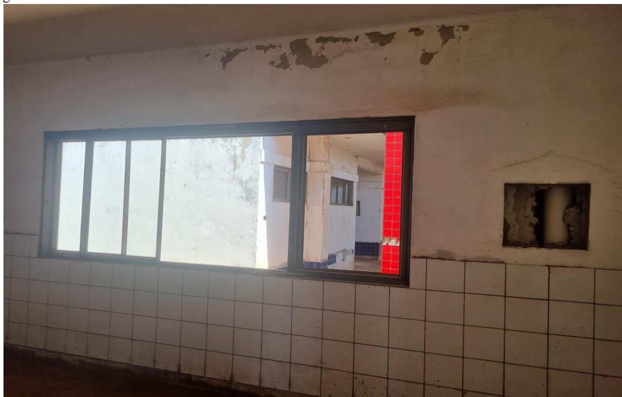
Imagem 06: Sala dos professores, sem instalação dos vidros, portas, sem instalação dos componentes elétricos, com pontos faltando revestimento cerâmico devido os mesmos se descolarem da alvenaria, piso em granitina não finalizado. Fonte: O autor.
