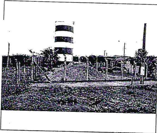
Figura 05 — Vista da caixa d'água pública.
